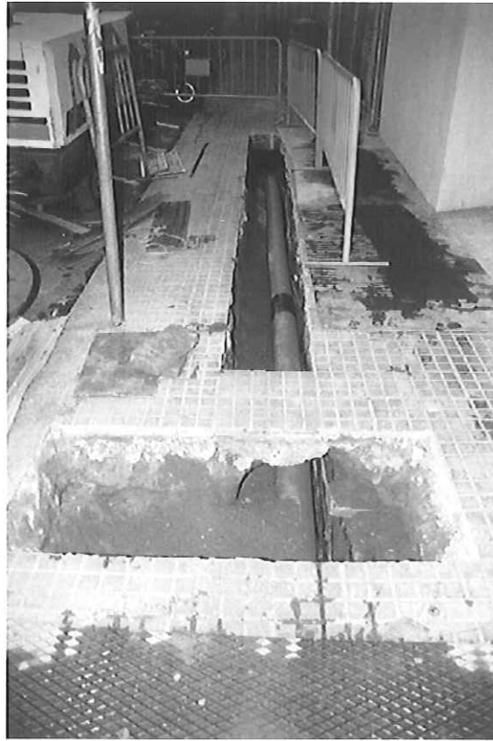
Imatge 4. Vista general del primer tram de la Rasa 1, després de ser excavada
