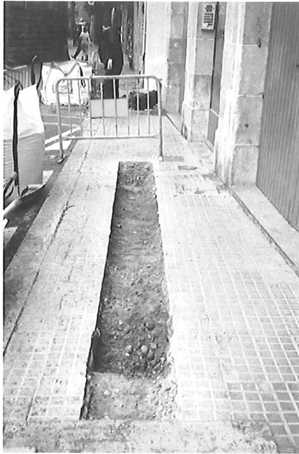
Imatge 5. Vista del tram final de la rasa una vegada extret el paviment
