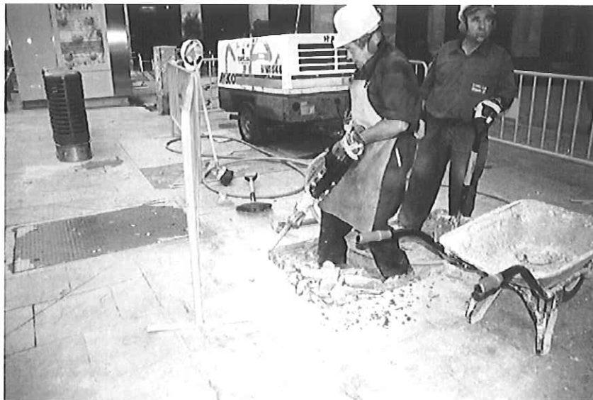
Imatge 6. Treballs d'obertura amb martell pneumàtic de la Cala 2, plaça Vicenç Martorell
